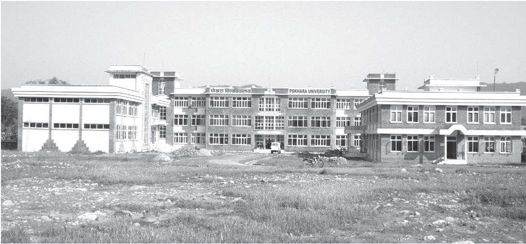
२०५८ सालमा निर्मित प्राज्ञिक भवन कम्प्लेक्स
